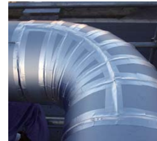
▲既設板金の補修用途
