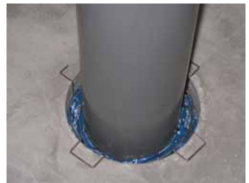
図1 イチジカン - 耐火パック 硬質塩ビ管貫通部(床)
