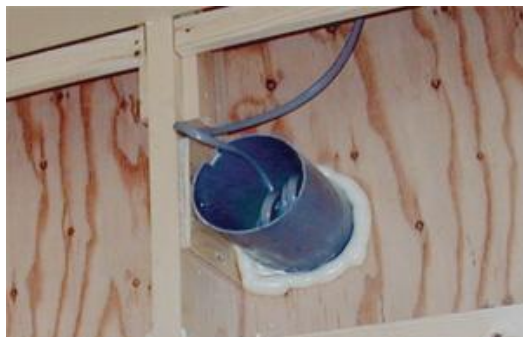
住宅の配管穴の埋め戻し
