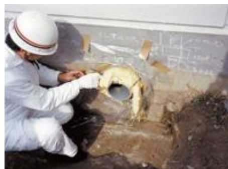
工場等の配管穴の埋め戻し
