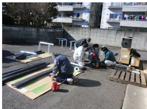
※チューブについてはアーマフレックスのケースにあるゲージを活用し制作した。(エルボ、チューブ)
