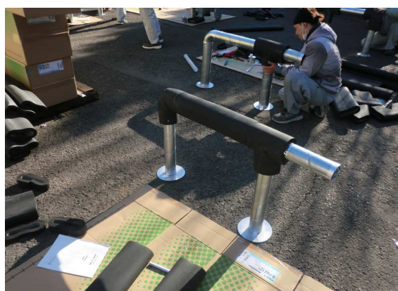
※エルボ、チーズと一部完了した架台
