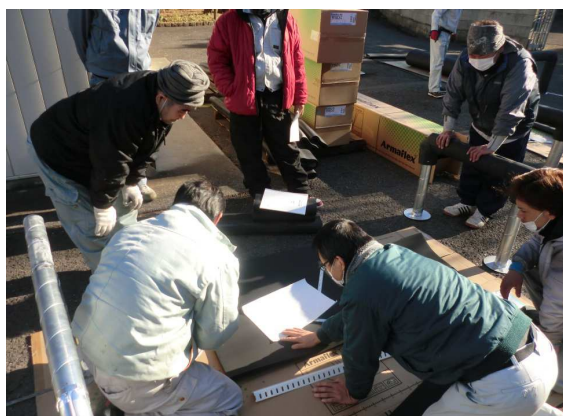
※作業途中の一部。シートからエルボを製作中。 ※先にもとになる型を作っており比較的早めに制作ができた。
