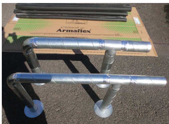
※施工用の架台。太管、細管の2種類
